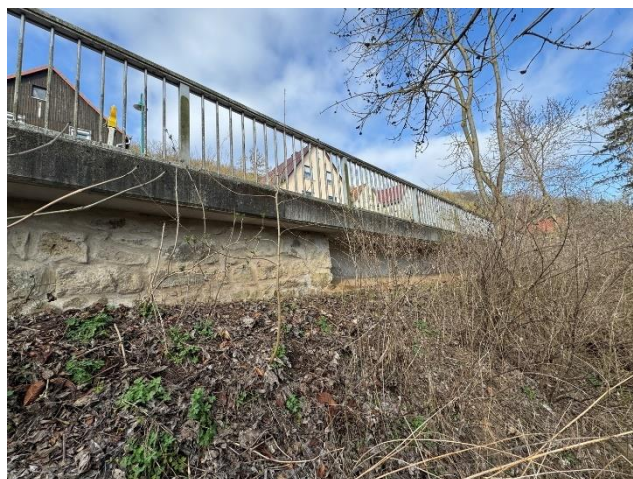
Abb. 6: TBW A auf Höhe Haus 5, links Natursteinverblendung, rechts Beton mit Natursteinunterlage (Blickrichtung NW)
